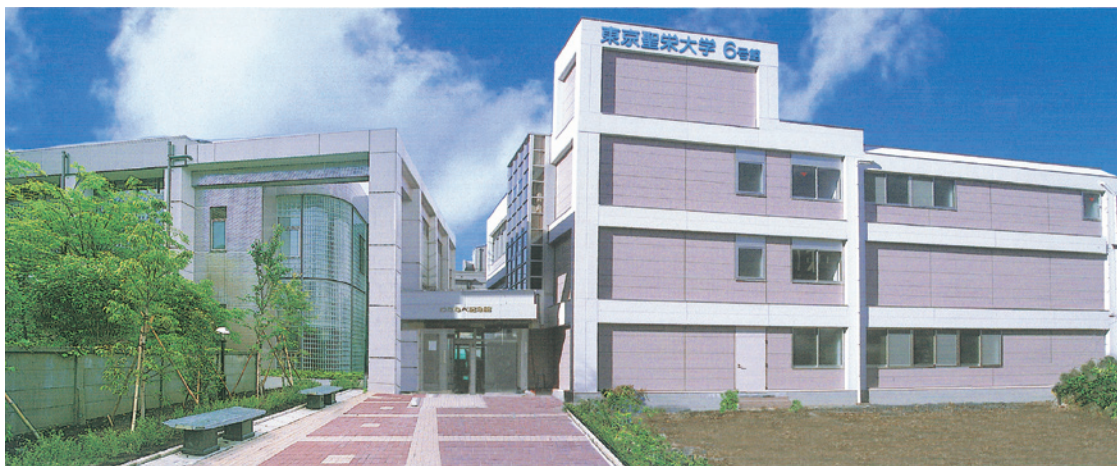
6号館完成（機器分析室・研究室 H18. 4）
