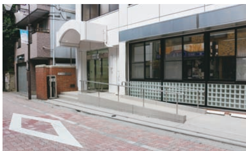
玄関スロープ新設
